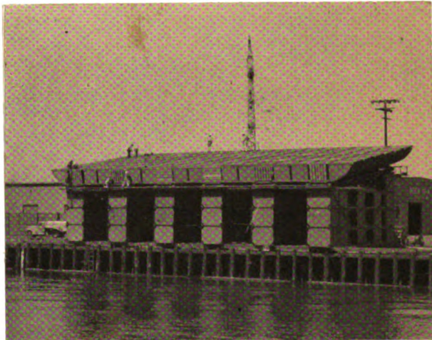
Fig. 26. 6x18 steel pontoon unit.
