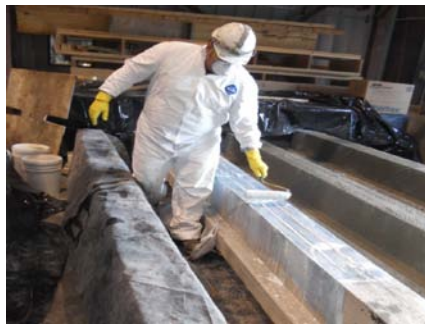
(a) Application of a VG primer layer
