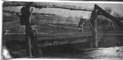
No. 197. w. pk. hw. br. 10' l. x 13' wd. abut. st. cn poor h. a. w. 2' str. 10' wd. x 2' d., f. banks low
