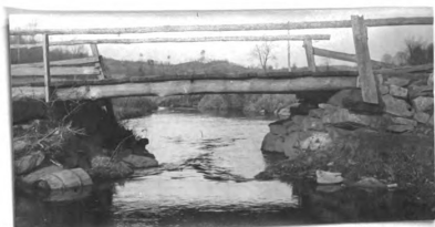
No. 190. w. pk. hw. br. 16.8' l. x 14' wd. abut. st. cn good h. a. w. 5.4' str. 10' wd. x 1.4' d., f. banks low
