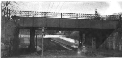
No. 18. s. gir. R. R. br. 55' l. x 33' wd. abut. st. cn good h. a. r. 16' d. of gir. 3.3'
