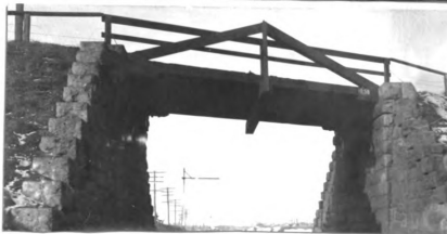
No. 48. w. k.p. hw. br. 32' l. x 20' wd. abut. st. cn good h. a. r. 19.7'
