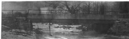
No. 70. con. hw. br. (rein. s. gir) 38.4' l. x 19' wd. d. of gir. 1.5' abut. st. cn good h. a. w. 8' str. 25' wd. x 2' d., f. banks low
