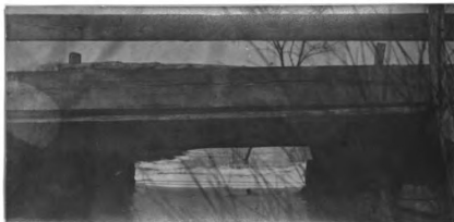
No. 210. w. pk. hw. br. 15' l. x 15' wd. abut. st. cn poor h. a. w. 3.8' banks low
