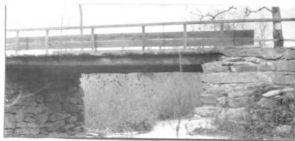
No. 11. w. pk. hw. br. 30' l. x 19' wd. abut. st. cn good h. a. w. 12' str. 25' wd. x 2.5' d., f. banks sloping
