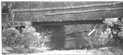
No. 146. w. pk. hw. br. 17' l. x 14' wd. abut. st. cn good h. a. w. 4' str. 15' wd. x 2' d., f. banks low
