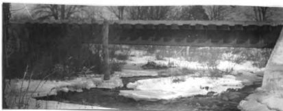
No. 73. w. E. R. br. (s. gir.) 30' l. x 7' wd. d. of gir. 1.8' abut. con. cn good h. a. w. 5.8' str. 20' wd. x 1' d., f. banks low
