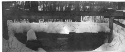
No. 108. w. pk. hw. br. 10' l. x 13' wd. abut. st. cn poor h. a. w. 2.6' str. 8' wd. x 1' d., f. banks low
