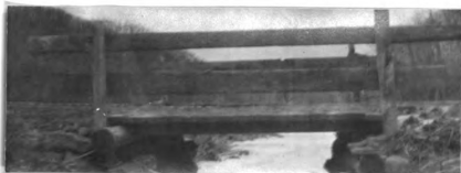
No. 219. w. pk. hw. br. 9.6' l. x 12' wd. abut. w. cn poor h. a. w. 3' str. 10' wd. x 1' d., f. banks low
