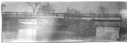
No. 10. w. pk. hw. br. 16' l. x 12' wd. abut. st. cn poor h. a. w. 6' str. 12' wd. x 2' d., n.f. banks low
