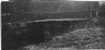
No. 191. w. pk. hw. br. 19' l. x 14.6' wd. abut. st. cn good h. a. w. 4' str. 10' wd. x 3' d., f. banks low
