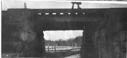
No. 90. s. gir. R. R. br. 14.5' l. x 14' wd. abut. st. cn good d. of gir. 1' h. a. r. 11'
