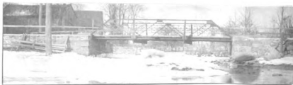
No. 71. s. Warren tr. hw. br. 42.8' l. x 16' wd. d. of gir. .5' h. a. w. 6.6' str. 20' wd. x 1' d., f. banks low
