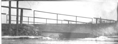
No. 64. con. hw. br. (rein. s. gir.) 21.4' l. x 14.6' wd. d. of gir. .9' abut. st. cn good h. a. w. 4.8' str. 18' wd. x 2' d., f. banks low
