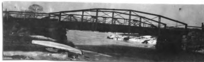
No. 23. s. Pratt tr. hw. br. 62' l. x 17' wd. abut. st. cn good h. a. w. 9' str. 55' wd. x 8' d., n.f.
