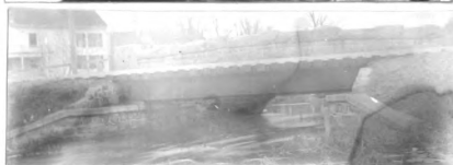
No. 50. st. Ar. hw. & s. gir. E. R. br. 20.5' 1. x 21.8' wd. abut. st. cn good h, a. w. 5.6' str. 18.5' wd. x 1.7' d., f. banks low and marshy
