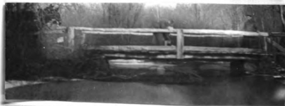
No. 196. w. pk. hw. br. 23.1' l. x 12' wd. abut. st. cn poor h. a. w. 2.7' str. 20' wd. x 3' d., f. banks low
