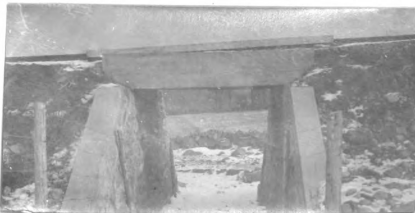
No. 33. w. E. R. br. 7.8' l. x 11' wd. abut. st. cn good h. a. r. 9' fill 5' h. x 500' l.
