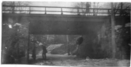
No. 86. s. gir. R. R. br. 30.8' l. x 26.9' wd. d. of gir. 3.6' abut. st. cn good h. a. r. 17'
