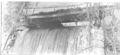
No. 131. w. pk. hw. br. 17' l. x 11.6' wd. abut. st. cn poor h. a. w. 2.9' str.15'wd.x1'd.,f. fill 5' h. x 300'l.
