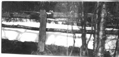
No. 171. w. pk. hw. br. 13.9' l. x 14' wd. abut. st. cn poor h. a. w. 3.4' str. 10' wd. x 1.6' d., f. banks low
