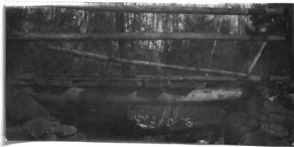
No. 201. w. pk. hw. br. 10' 1. x 12' wd. abut. st. cn poor h. a. w. 4.6' str. 8' wd. xl' d., f. banks low
