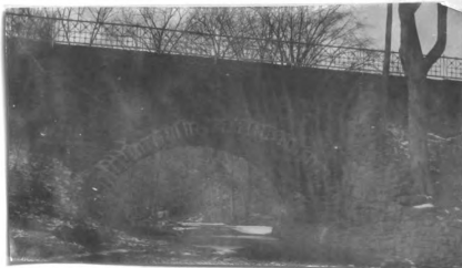
No. 203. st. Ar. hw br. 28' l. x 25' wd. abut. st. cn good h. a. w. 24' str. 25' wd. x 1' d., f. banks low fill 20' h. x 100' l.
