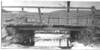
No. 95. w. pk. hw. br. 14.2' l. x 12.5' wd. abut. st. cn poor h. a. w. 3' str. 12' wd. x 1' d., f.
