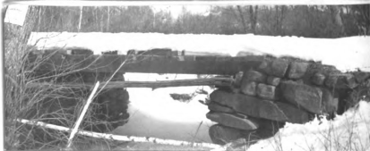
No. 158. w. pk. hw. br. 13' l. x 14' wd. abut. st. cn fair h. a. w. 5.4' str. 6' wd. x 1.5' d., f. banks low
