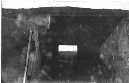
No. 21. s. gir. R. R. br. 6' l. x 33' wd. d. of gir. .6' abut. st. cn good h. a. r. 7'
