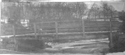
No. 64 \frac{1}{2} . w. pk. hw. br. 26' l. x 15' wd. abut. st. cn poor h. a. w. 5' str. 20' wd. x 1' d., f. banks low
