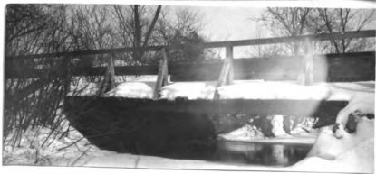
No. 119. w. pk. hw. br. 28' l. x 12' wd. abut. st. cn good h. a. w. 3.5' str. 20' wd. x 2' d., f. banks low
