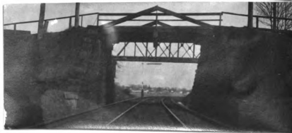
No. 69. w. k.p. hw. br. 31.8' l. x 20.2' wd. abut. st. on good h. a. r. 19' fill 7.5' h. x 200' l.
