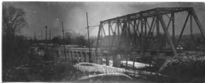
No. 68. con. & s. Pratt tr. E. R. br. 111.5' l. x 7' wd. d. of gir. 1.5' h. a. r. 25.9' abut. con. on good con. approach 243' l. x 13.3' wd.
