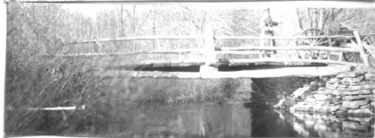
No. 147. w. pk. hw. br. 24' l. x 14' wd. abut. st. cn good. h. a. w. 5' str. 20' wd. x 4' d., f. banks low
