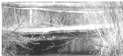
No. 39. w. pk. hw. br. 9' l. x 16' wd. abut. st. cn poor h. a. w. 2' str. 8' wd. x 1' d., f. banks low
