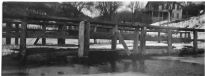
No. 107. w. pk. hw. br. 10.6' l. x 14' wd. abut. st. cn good h. a. w. 1' str.10'wd.x5'd.,n.f. banks low
