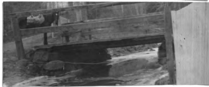
No. 99. w. pk. hw. br. 10' l. x 16' wd. abut. st. on good h. a. w. 3' str. 8' wd. x 1' d., f. banks low
