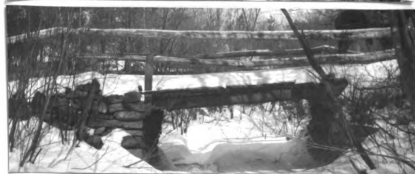
No. 118 \frac{1}{2} . w. pk. hw. br. 15' l. x 12' wd. abut. st. cn good h. a. w. 5.6' str. 10' wd. x 1' d., f. banks sloping
