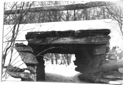
No. 125. w. pk. hw. br. 16' l. x 12.3' wd. abut. st. cn good h. a. w. 5' str. 7' wd. x 1' d., f. banks low
