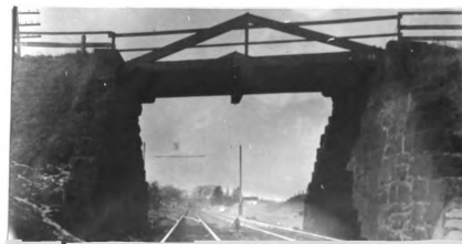
No. 36. w. k.p. hw. br. 34' l. x 18' wd. abut. st. cn good h. a. r. 20'
