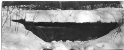
No. 116. w. pk. hw. br. 7' l. x 11' wd. abut. st. cn good h. a. w. 2' str. 6' wd. x 1.6' d., f. banks low
