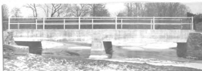
No. 217. con. hw. br. (rein. s. gir.) 48' l. x 20' wd. d. of gir 1' abut. con. cn good h. a. w. 6.8' str. 40' wd. x 2' d., f. banks low
