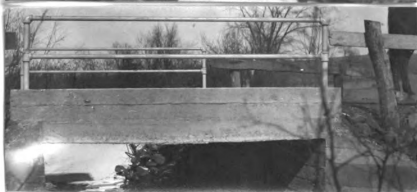
No. 220. con. hw. br. (rein. s. gir.) 7.7' l. x 15' wd. abut. con. cn good d. of gir. .9' h. a. w. 6.4' str. 6' wd. x 1.5' d., f. banks low
