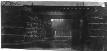
No. 47. s. gir. R. R. br. 19.6' l. x 14' wd. d. of gir. 2' abut. st. cn good h. a. w. 11.8' str. 18' wd. x 1' d., n.f. banks low fill 10' h. x 900' l.
