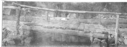
No. 88. w. pk. hw. br. 10' l. x 12' wd. abut. st. cn poor h. a. w. 2' str. 8' wd. x 3' d., n.f. banks low
