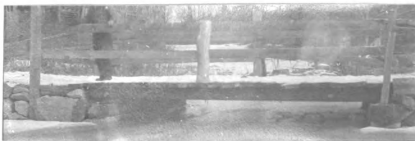
No. 91. w. pk. hw. br. 18.6' l. x 12' wd. abut. st. cn poor h. a. w. 2.2' str. 14' wd. x 7' d., n.f. banks low
