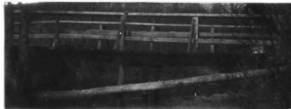
No. 19. w. pk. hw. br. 24' l. x 11' wd. abut. st. cn good h. a. w. 3.8' str. 20' wd. x 2.4' d., f. banks low
