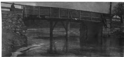
No. 58. w. pk. hw. br. 44' l. x 15' wd. abut. st. cn fair h. a. w. 9' str. 60' wd. x 4' d., n.f. banks low
