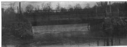
No. 63. s. gir. hw. br. 26' l. x 14' wd. d. of gir. .9' abut. st. cn good h. a. w. 4.8' str. 23' wd. x 4' d., n.f. banks low
