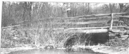
No. 145. w. pk. hw. br. 15' l. x 15' wd. abut. st. cn good h. a. w. 3' banks low
