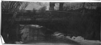
No. 211. w. pk. hw. br. 10.6' l. x 18.4' wd. abut. st. cn poor h. a. w. 2.4' str. 8' wd. x 2' d., f. banks low
