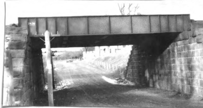
No. 20. s. gir. R. R. br. 33' l. x 33' wd. d. of gir. 3' abut. st. cn good h. a. r. 15'
