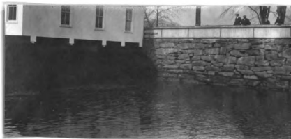
No. 17. st. Ar. hw. br. 16' l. x 75' wd. abut. st. cn good h. a. w. 9.6' str. 40' wd. x 2' d., n. f. banks built-up
