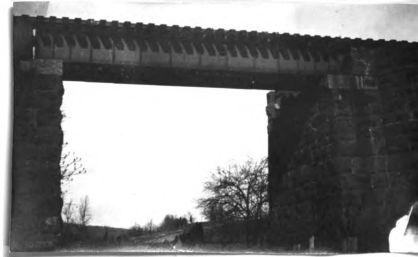
No. 227. s. gir. R. R. br. 36.5' l. x 11' wd. d. of gir. 3.4' abut. st. cn good h. a. w. 26.9' str. 8' wd. xl' d., f. banks low fill 20' h. x 800' l.
