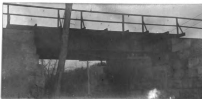
No. 79. s. gir. R. R. br. 31.2' l. x 26.7' wd. d. of gir. 1.4' abut. st. cn good h. a. w. 14' fill 10' h. x 1500 l.
