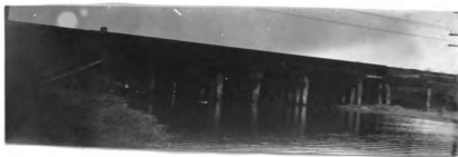
No. 59. w.R.R.tres.(s.gir.) 63' l. x 28' wd. d. of gir. 1.4' abut. w. cn good h. a. w. 10.6' str.40'wd.x2'd.,n.f. banks low fill 9' h. x 800' l.
