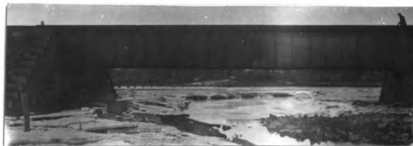
No. 94. s. gir. R. R. br. 77.5' l. x 14' wd. d. of gir. 7' abut. st. cn good h. a. w. 20' str. 20' wd. x 1' d., n.f. banks low fill 15' h. x 500' l.
