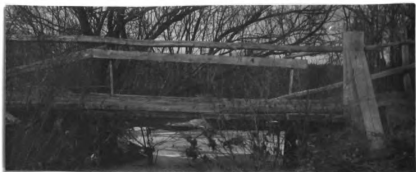
No. 212. w. pk. hw. hr. 14' l. x 14' wd. abut. st. cn poor h. a. w. 5' str. 10' wd. x 1.4' d., f. banks sloping
