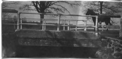
No. 209. con. hw. br. (rein. s. gir.) 12' l. x 22' wd. abut. st. cn good h. a. w. 4' banks low
