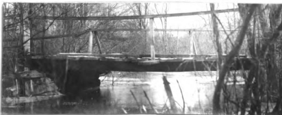
No. 46. w. pk. hw. br. 17.3' l. x 13.2' wd. abut. st. cn poor h. a. w. 3.2' str. 12' wd. x 3.4' d., n.f. banks low
