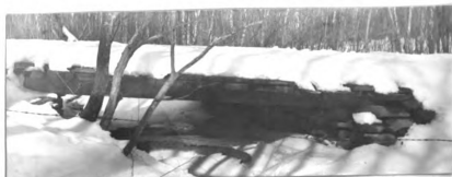
No. 113. w. pk. hw. br. 15' l. x 12' wd. abut. st. cn good h. a. w. 2.6' str. 10' wd. x 1' d., f. banks low
