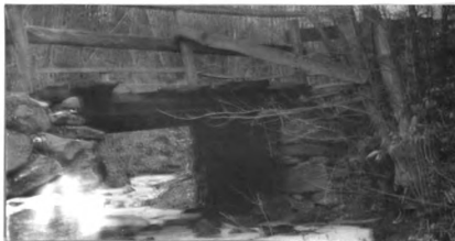
No. 100. w. pk. hw. br. 13' l. x 15' wd. abut. st. cn good h. a. w. 6' str. 19' wd. x 1' d., f. banks steep
