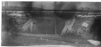
No. 32. w. E. R. br. 11' l. x 18' wd. abut. w. cn good h. a. w. 6' str. 10' wd. x 3' d., n.f. banks low fill 2' h. x 1300' l.
