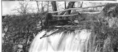
No. 129. w. pk. hw. br. 17.7' l. x 13' wd. abut. st. cn poor h. a. w. 3' str.15'wd.x1.6'd.,f. banks low fill 5' h. x 300' l.
