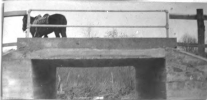
No. 216. con. hw. br. (rein. s. gir.) 11' l. x 16.8' wd. abut. con. cn good h. a. w. 7.6' str. 10' wd. x 1' d., f. banks sloping
