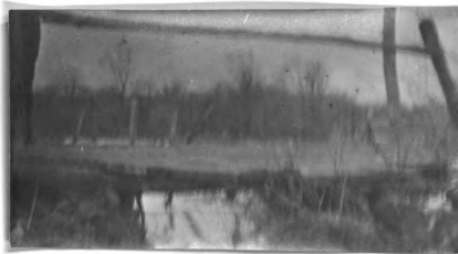
No. 224. w. pk. hw. br. 9.6' l. x 13' wd. abut. st. cn poor h. a. w. 2' str. 6' wd. xl' d., f. banks low
