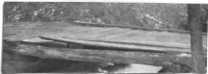
No. 223. w. pk. hw. br. 13' l. x 13' wd. abut. st. cn poor h. a. w. 3' str. 10' wd. x 1' d., f. banks low
