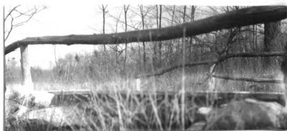
No. 172. w. pk. hw. br. 8' l. x 14.3' wd. abut. st. cn good h. a. w. 3' str. 5' wd. x 1' d., f. banks low
