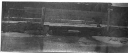
No. 84. w. pk. hw. br. 9.8' l. x 15' wd. abut. w. cn poor h. a. w. 1' str. 6' wd. x 2' d., n.f. banks low
