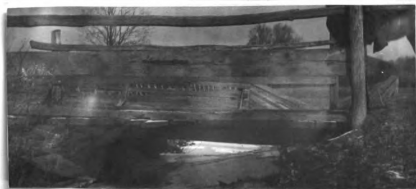
No. 200. w. pk. hw. br. 13' 1. x 13' wd. abut. st. cn poor h. a. w. 4' str. 10' wd. xl' d., f. banks sloping
