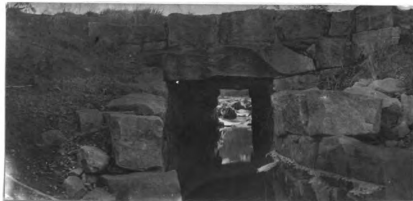
No. 22. st. R. R. br. 5' l. x 55' wd. abut. st. cn good h. a. w. 9' str. 5' wd. x 1' d., n.f. banks low and marshy fill 6' h. x 1500' l.
