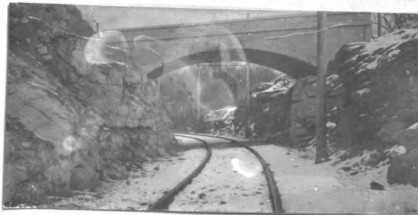
No. 78. con. Ar. hw. br. 50' l. x 18' wd. abut. con. cn good h. a. r. 17'
