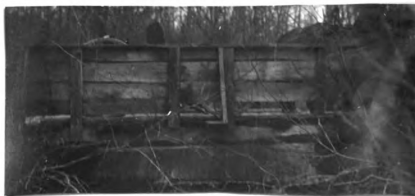
No. 53. w. pk. hw. br. 18.3' 1. x 15.2' wd. abut. st. cn good h. a. w. 9' str. 17' wd. x 2' d., f. banks low
