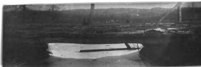
No. 214. w. pk. hw. br. 15.1' l. x 11' wd. abut. st. cn poor h. a. w. 3' str. 10' wd. x 1.6' d., f. banks low
