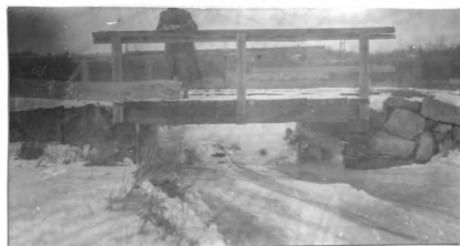
No. 81. w. pk. hw. br. 12.6' l. x 21' wd. abut. w. cn poor h. a. w. 3.5' str. 11' wd. x 3' d., n.f. banks low
