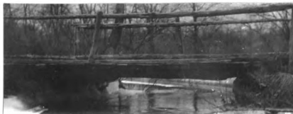
No. 49. w. pk. hw. br. 15' 1. x 12' wd. abut. st. cn good h. a. w. 3' str. 12' wd. x 1' d., f. banks low
