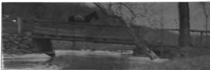
No. 102. w. pk. hw. br. 25' l. x 13' wd. abut. st. cn good h. a. w. 4.6' str. 20' wd. x 2' d., f. banks low
