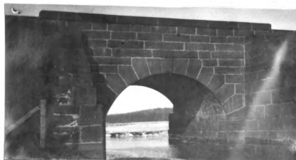
No. 16. st. Ar. R. R. br. 22' l. x 22' wd. abut. st. cn good h. a. w. 21' str.22'wd.x2'd.,n.f. banks low and marshy fill 10' h. x 500' l.
