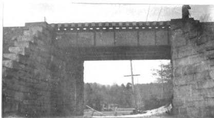
No. 87. s. gir. R. R. br. 29' l. x 14' wd. d. of gir. 3.6' abut. st. cn good h. a. r. 18.5' fill 15' h. x 350' l.
