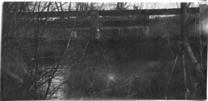
No. 160. w. pk. hw. br. 21.1' l. x 12.4' wd. abut. st. cn fair h. a. w. 5.2' str. 15' wd. x 1.8' d., f. banks low
