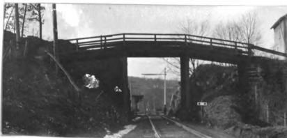
No. 170. w. pk. hw. br. 56' l. x 12' wd. abut. st. cn good h. a. r. 19'
