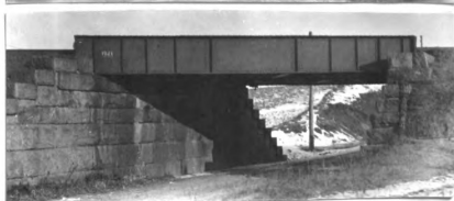
No. 51. s. gir. R. R. br. 33' 1. x 22' wd. d. of gir. 1.8' abut. st. cn good h. a. r. 12.8' fill 7' h. x 900' l.
