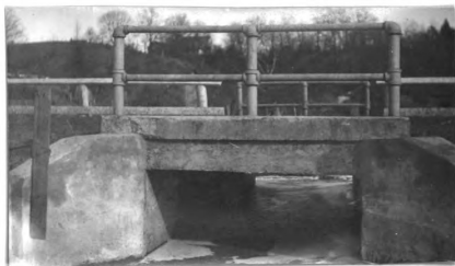
No. 206. con. hw. br. (rein. s, gir) 6' l. x 22' wd. abut. con. cn good h. a. w. 3' str. 6' wd. x 1' d., f. banks low
