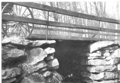
No. 27. w. pk. hw. br. 8.4' l. x 14' wd. abut. st. cn good h. a. w. 7' str. 5' wd. x 2' d., f. banks sloping
