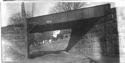
No. 52. s. gir. R. R. br. 41' 1. x 22' wd. d. of gir. 1.8' abut. st. cn good h. a. r. 16' fill 8' h. x 1000' l.
