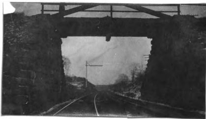
No. 85. w. k.p. hw. br. 29' l. x 19' wd. abut. st. cn good h. a. r. 19, 7'
