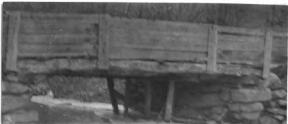
No. 103. w. pk. hw. br. 25' l. x 15' wd. abut. st. cn poor h. a. w. 5.6' str. 20' wd. x 1.6' d., f. banks low
