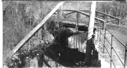
No. 177. s. Warren tr. hw. br. 48' l. x 20' wd. d. of gir. .5' abut. st. cn good h. a. w. 8.8' str. 17' wd. x 1.4' d., f. banks sloping fill 2' h. x 500' l.
