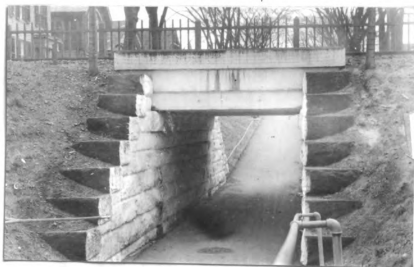
No. 15. s. gir. R. R. br. 10' l. x 27' wd. abut. st. cn good h. a. r. 12'
