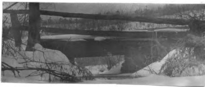
No. 96. w. pk. hw. br. 10' l. x 16' wd. abut. st. on poor h. a. w. 2.6' str. 5' wd. x 1.6' wd., n.f. banks low
