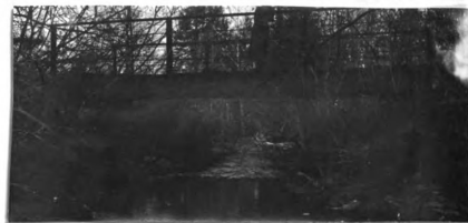
No. 173. s. gir. hw. br. 32' l. x 16.2' wd. d. of gir. 1.5' abut. st. cn good h. a. w. 7.8' str. 15' wd. x 2' d., f. banks sloping
