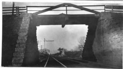
No. 38. w. k.p. hw. br. 32' l. x 20' wd. abut. st. cn good h. a. r. 19.7' fill 20' h. x 400' l.
