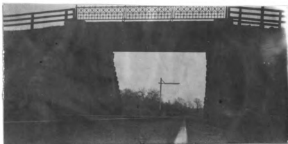
No. 9. s. gir. hw. br. 31' l. x 30' wd. d. of gir. 1.10' abut. st. cn good h. a. r. 20.4' fill 10' h. x 200' l.
