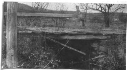
No. 183. w. pk. hw. br. 7' l. x 12' wd. abut. st. cn poor h. a. w. 3' str. 3' wd. x 1' d., f. banks low
