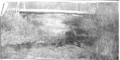
No. 189. w. pk. hw. br. 20.6' l. x 14' wd. abut. st. cn good h. a. w. 5.6' str. 8' wd. x 1.2' d., f. banks low
