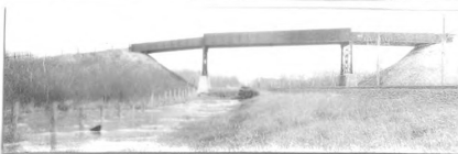
No. 5. s. gir. hw. br. 145' l. x 20' wd. d. of gir. 5.6' abut. st. cn good h. a. r. 20.5' fill 10' h. x 200' l.
