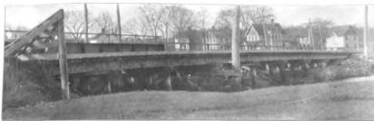
No. 67. w.E.R.tres.(s.gir.) 132' l. x 7' wd. d. of gir. 1.3' h. a. w. 8.8' str.40'wd.x2'd.,n.f. banks low fill 2' h. x 500' l.
