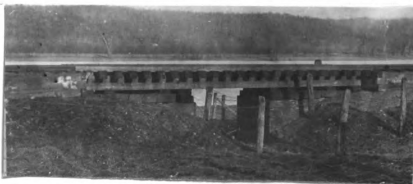
No. 159. w. R.R. tres. (s. gir.) 31.4' l. x 7.2' wd. d. of gir. 1.4' h. a. w. 8' banks low abut. st. cn good fill 2' h.
