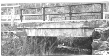
No. 25. con. hw. br. (rein. s. gir.) 12' l. x 22' wd. abut. st. cn good h. a. w. 8' str. 10' wd. x 1' d., f. banks sloping
