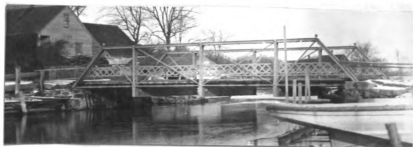
No. 56. s. Pratt tr. hw. br. 49' l. x 18.5' wd. d. of gir. .8' abut. st. cn good h. a. w. 6.9' str. 40' wd. x 9' d., n.f. banks low
