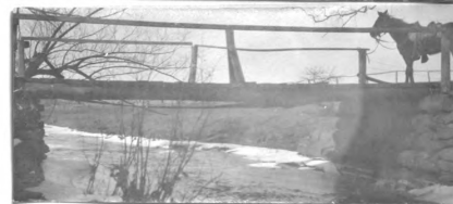
No. 204. w. pk. hw. br. 26' l. x 12' wd. abut. st. cn good h. a. w. 6.6' str. 20' wd. x 2' d., f. banks low
