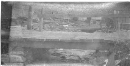
No. 202. w. pk. hw. br. 10' l. x 15' wd. abut. st. cn good h. a. w. 2' str. 8' wd. x 1' d., f. banks low
