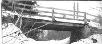
No. 175. w. pk. hw. br. 21.6' l. x 17' wd. abut. st. cn good h. a. w. 7' str. 15' wd. x 1.6' d., f. banks sloping
