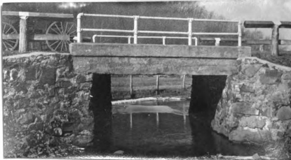
No. 218. con. hw. br. (rein. s. gir.) 15.4' l. x 21.4' wd. d. of gir. 1.5' abut. st. cn good h. a. w. 8' str. 14' wd. x 2' d., f. banks low
