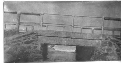
No. 205. con. hw. br. (rein. s. gir.) 10' l. x 22' wd. abut. st. cn good h. a. w. 5' str. 6' wd. x 1' d., f. banks low
