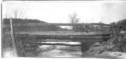
No. 195. w. pk. hw. br. 16' l. x 10' wd. abut. st. cn good h. a. w. 3' str. 10' wd. x 2' d., f. banks low
