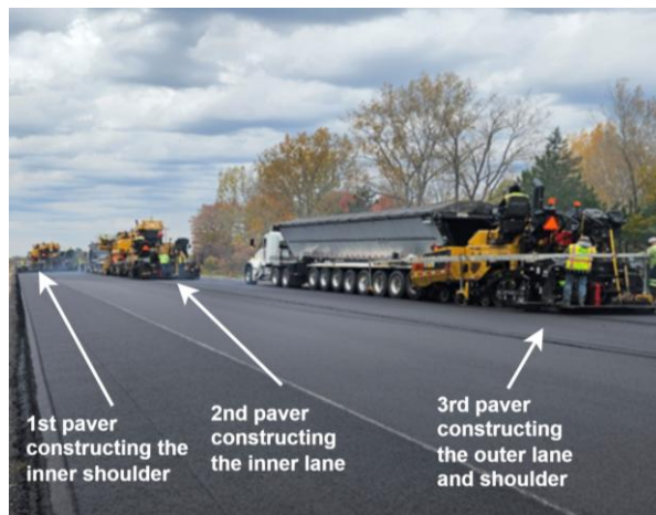
(d) Echelon paving at US-10, MI
