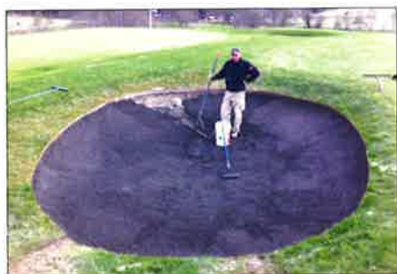
Ved byggingen av Vallda GC ved Göteborg ble det brukt dreneringsrør til å forme bunkeranten. Foto: Stefan Nilsson
