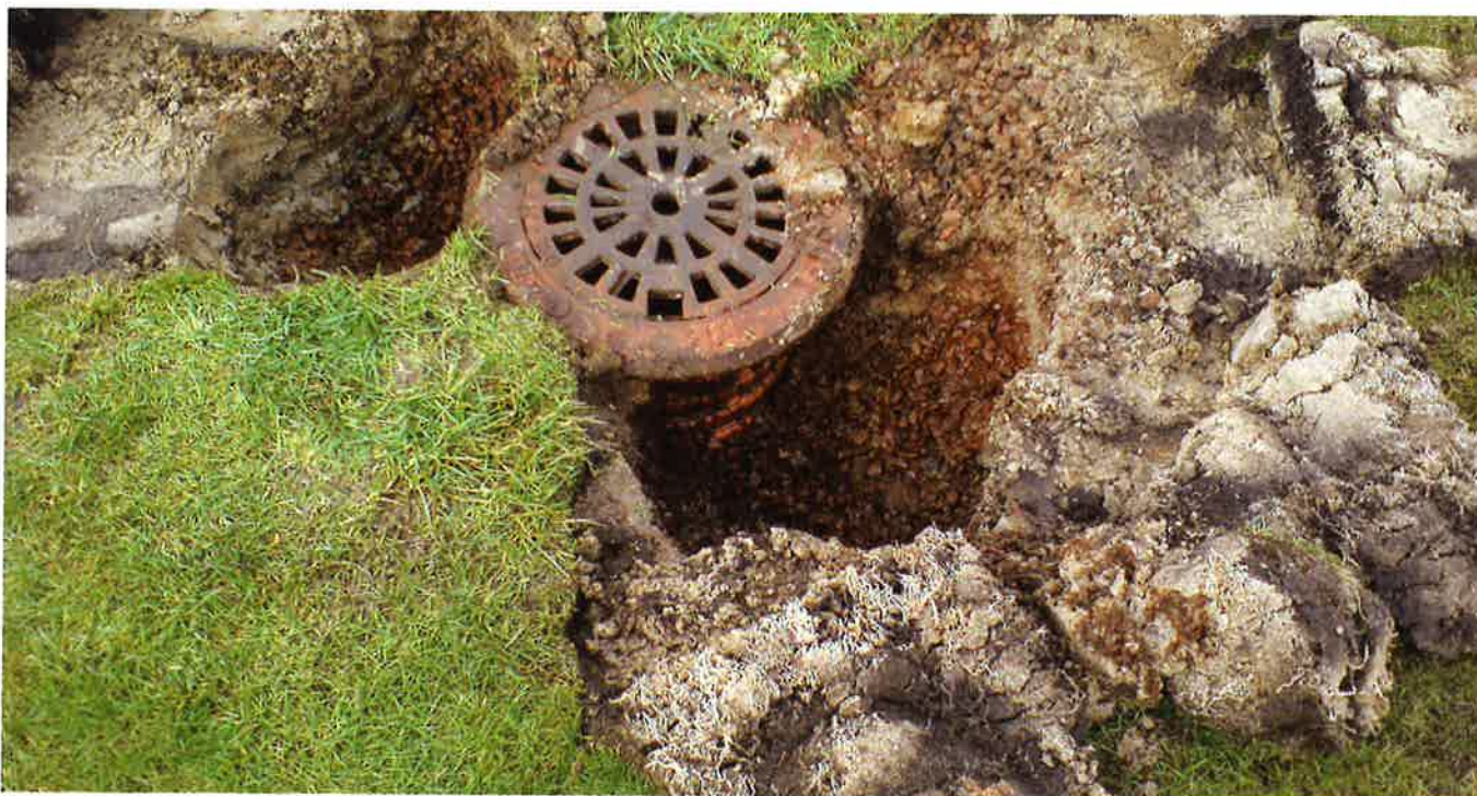
Også på sandcapet fairway kan det bli black layer der jorda ikke er drenert. Bildet er tatt av Terje Haugen på Bjaavann golfbane.
