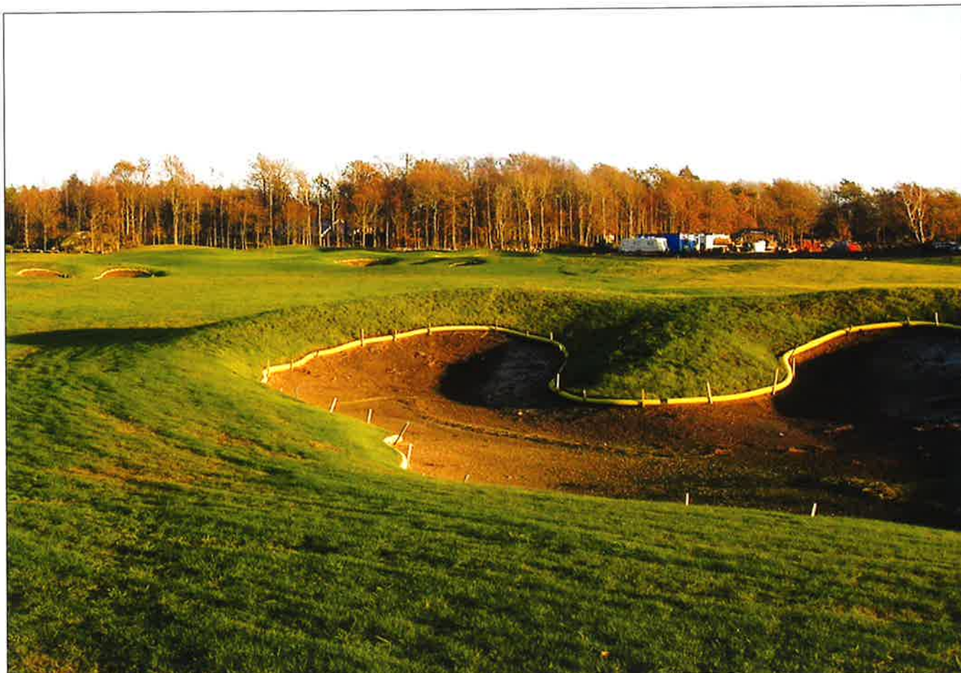
Ved byggingen av Vallda GC ved Göteborg ble det brukt dreneringsrør til å forme bunkeranten. Foto: Stefan Nilsson
