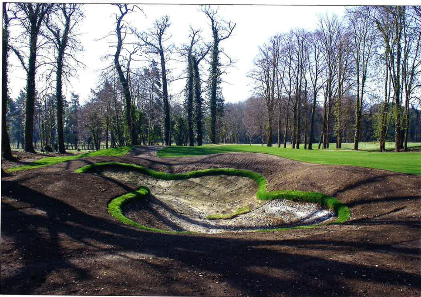
Bilde 13 Ferdigplen (gjærne skåret ut av banen før ombygging) kan brukes til å etablere faste kanter, og til å skille undergrunnen fra bunkersand. Foto: Ljubica Jovetic, Swan golf design.
