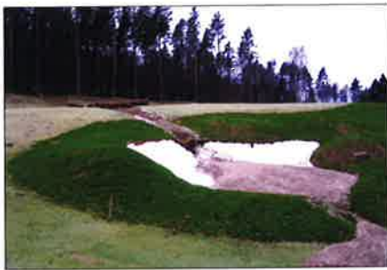
Selv om alt var gjort riktig på Hills ved Göteborg, var de uheldig med været og store problemer med erosjon under konstruksjonen. Foto: Merethe Brår Larsen
