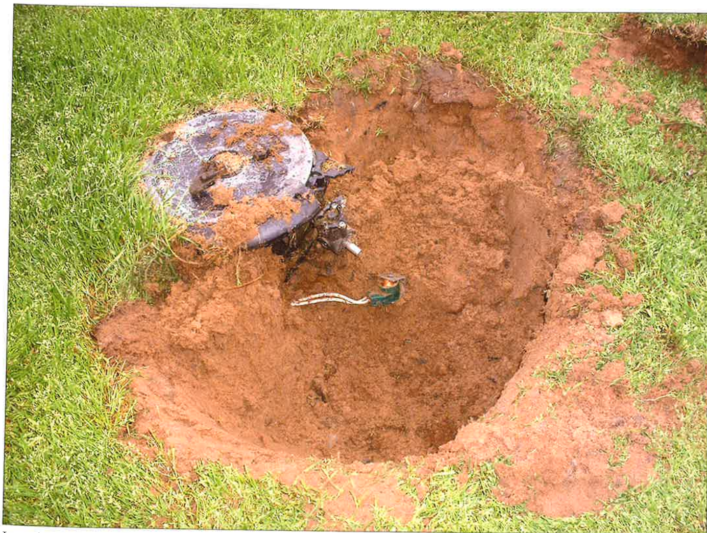
Lynnedslag i vanningsanlegg. Foto: Serhat Øzsatici, S48 Vanningsanlegg AS.
