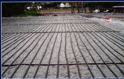
Varmekablene i treningsbanen. Disse er lagt oppå dremsmassen før vekstlaget ble lagt ut på samme måte som i hovedbanen.
