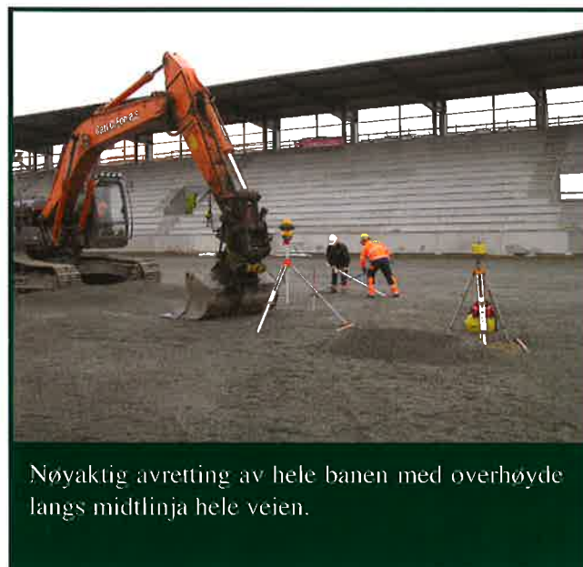
16.mai. Komprimering og sletting av drengrusen.
