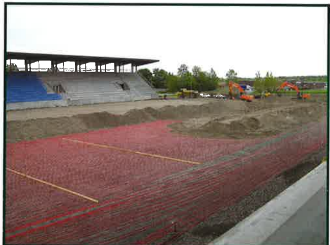
25.mai. Vekstlaget legges ut i kjøreranker på 1 meter tykkelse og deretter lagt ut i 35 cm. Slik unngås skadelig pakking. Legg merke til lektene som holder varmerøra på plass.
