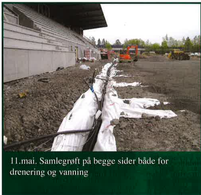
Dreneringsgrus under hele spilleflaten og i sugegrøftene
