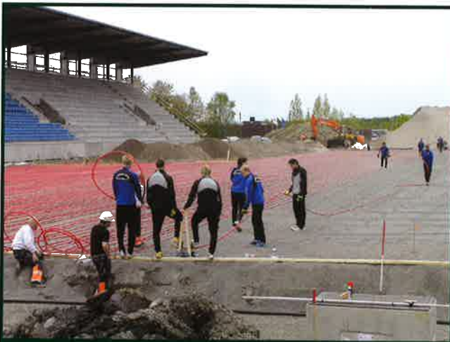
21.mai. Utlegging av varmekabler er en stor jobb og krevde mobilisering av fotballaget.
