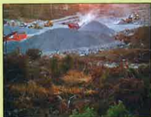
All stein som er brukt som drenering av banen er sprengt ut på stedet. Steinbruddet er blitt til drivingrange.
